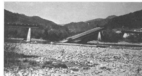
Il ponte sul fiume Vara a Padivarva all'epoca del crollo. Immediatamente a valle era in funzione un impianto di estrazione di inerti.
